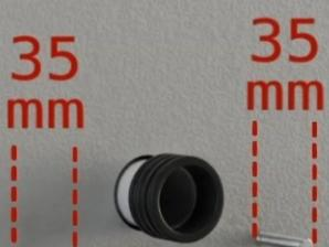
Отрегулируйте стержни крепления подвесного унитаза. Расстояние стержня должно составлять 35 мм от стены.
